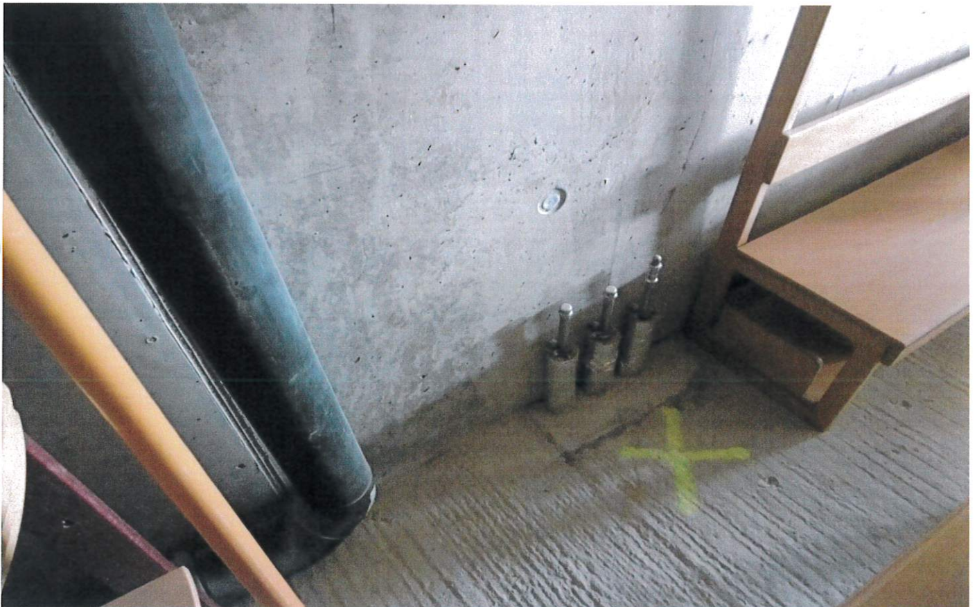
12. Zirkulation, Kalt- und Warmwasserleitungen im Abstellraum, ganz am Ende der Halle abgestopft. Nicht zulässig entsprechend Trinkwasserverordnung, da stehendes Wasser, Verkeimung und Legionellen Bildung. Spülstation muss eingebaut werden.
