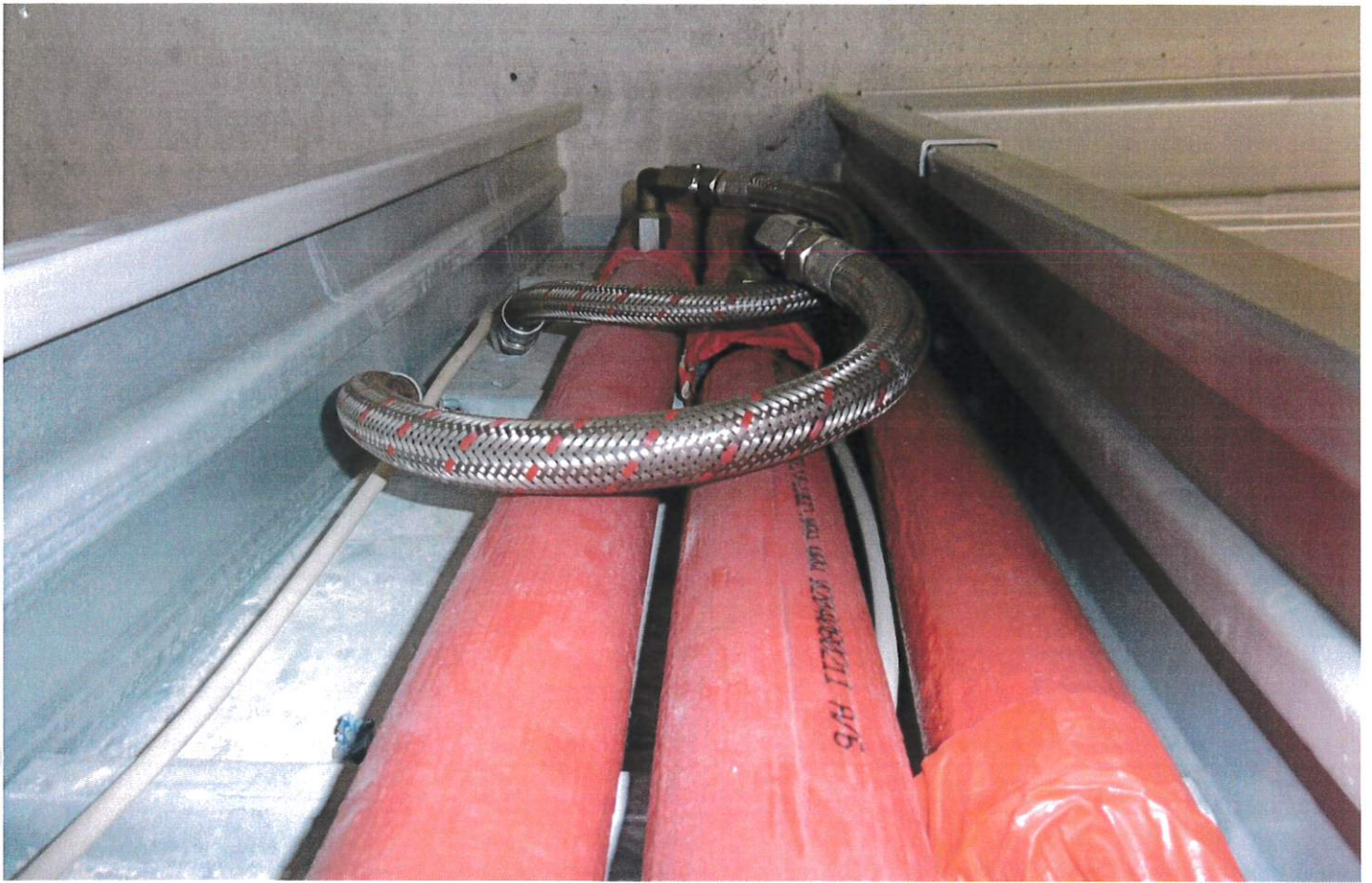
15. Schlecht beziehungsweise gar nicht gedämmte Kaltwasser- und Warmwasserleitungen über den Duschen. Nachisolierung erforderlich.
