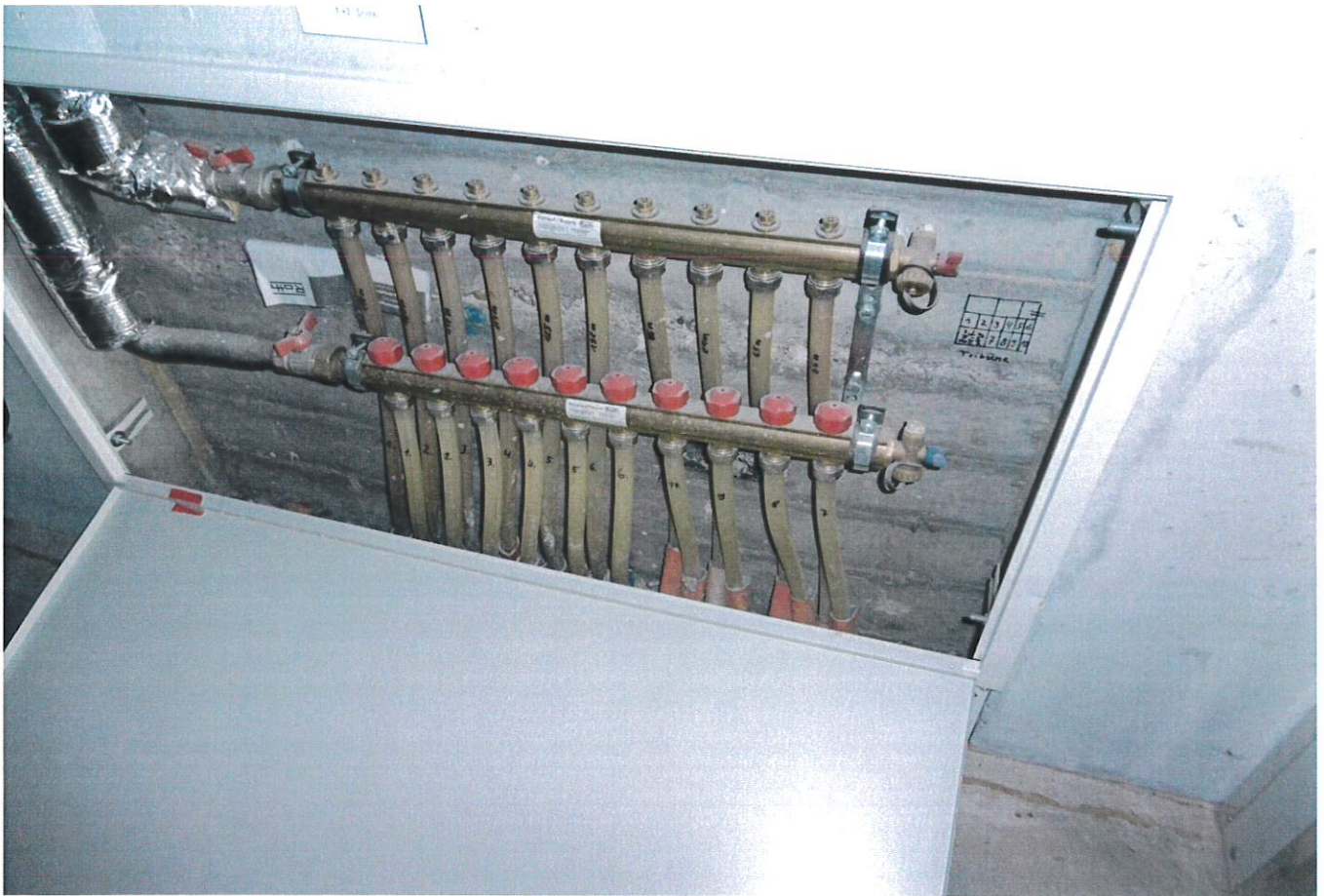
9. Fußbodenheizungsverteiler ohne elektrische Stellantriebe und Raumthermostate. Nicht zulässig! Nachrüstung.
