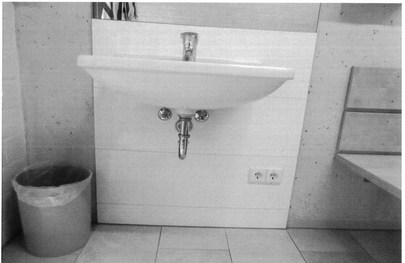
14. Waschbecken mit Selbstschlussventil ohne Spülfunktion. Nachrüstung mit Waschbeckenarmatur welche zeitabhängig spült, alle 72 Stunden. Trinkwasserverordnung.
