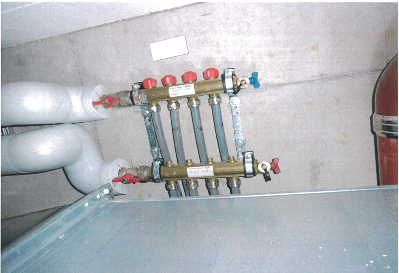
10. Fußbodenheizungsverteiler ohne elektrische Stellantriebe und Raumthermostate. Nicht zulässig! Nachrüstung.
