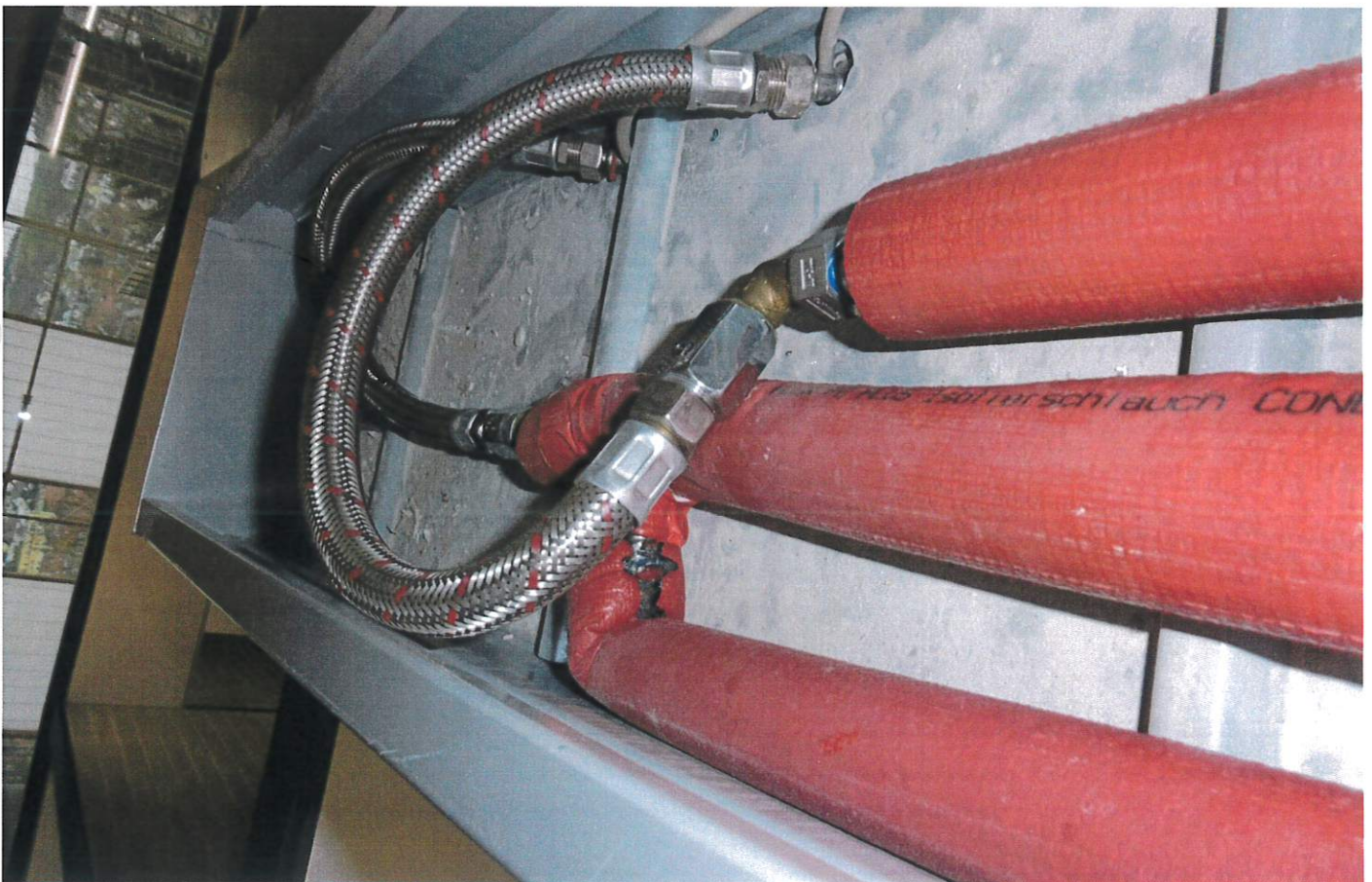
16. Schlecht beziehungsweise gar nicht gedämmte Kaltwasser- und Warmwasserleitungen über den Duschen. Nachisolierung erforderlich.
