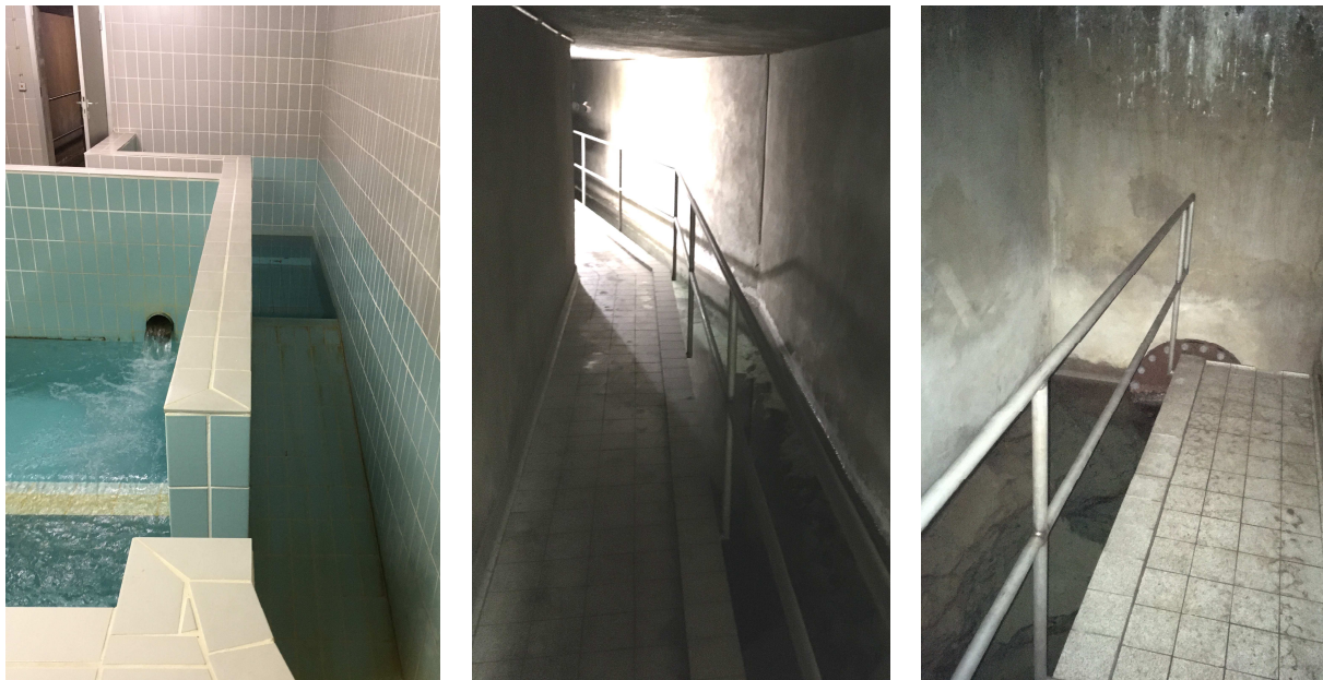
Abb. 2: Quellschacht und Sammelbecken der Gennenbachquelle
