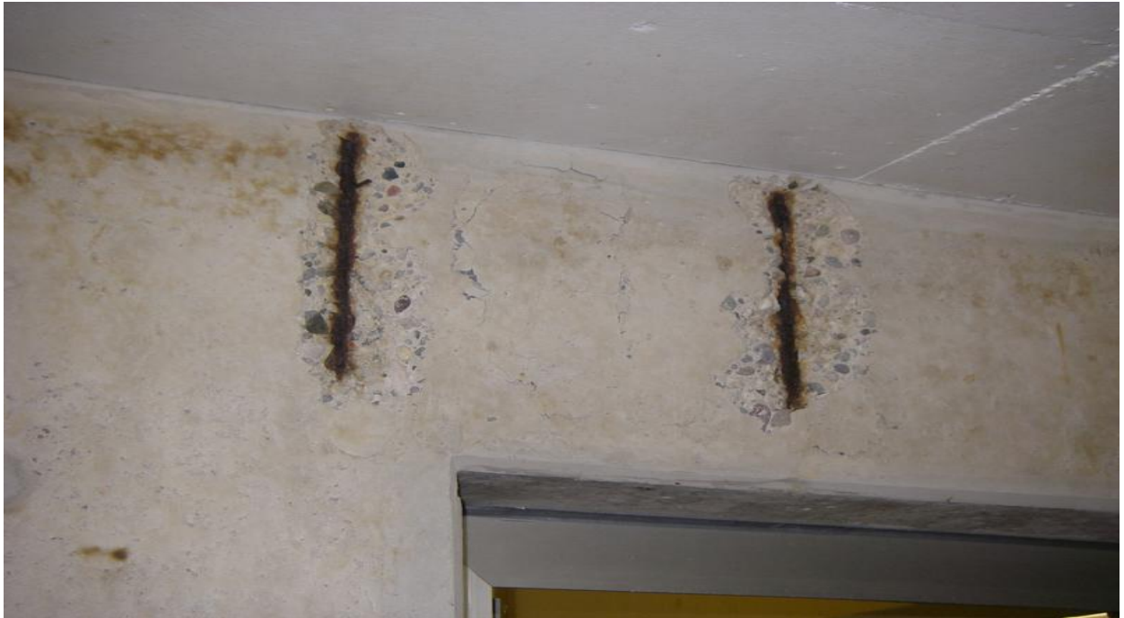
Abbildung 6: Betonschäden Hochbehälter Waldpark neu
