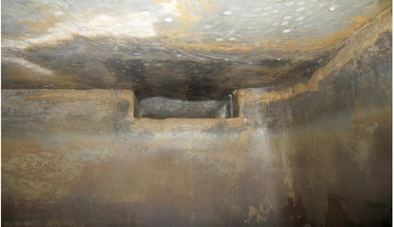
Abbildung 11: Entlüftung Wasserkammern Waldpark alt
