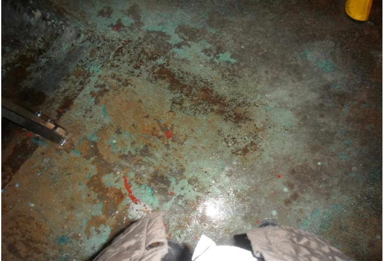
Abbildung 10: Beschichtung Wasserkammer Waldpark alt
