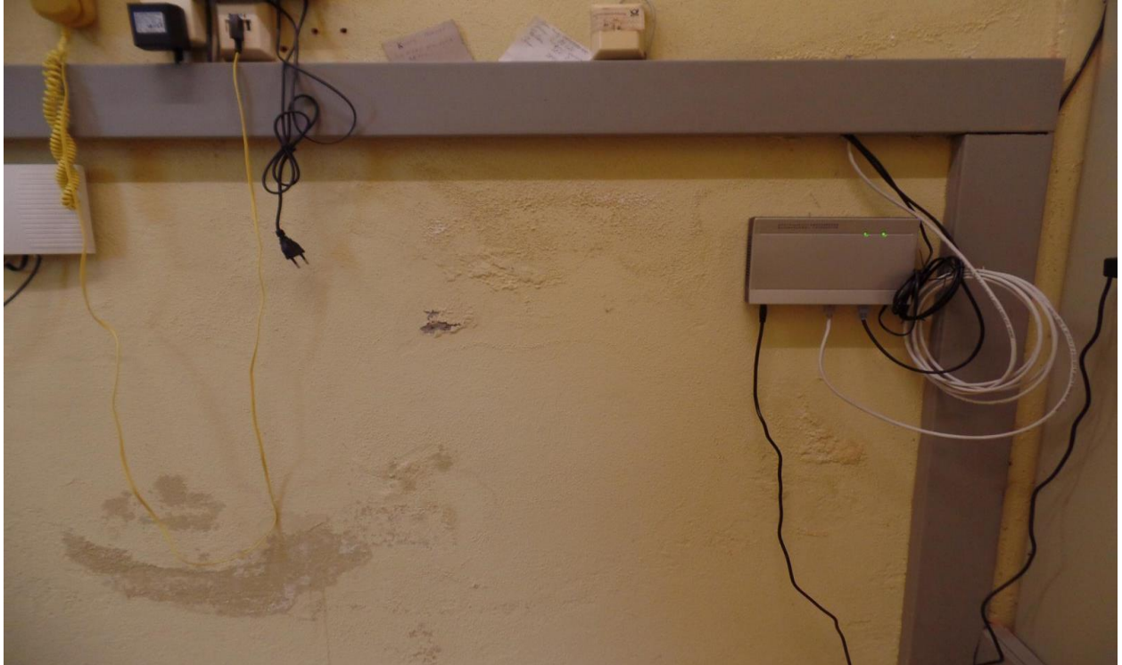
Abbildung 8: Feuchtigkeitsschäden Hochbehälter Waldpark neu
