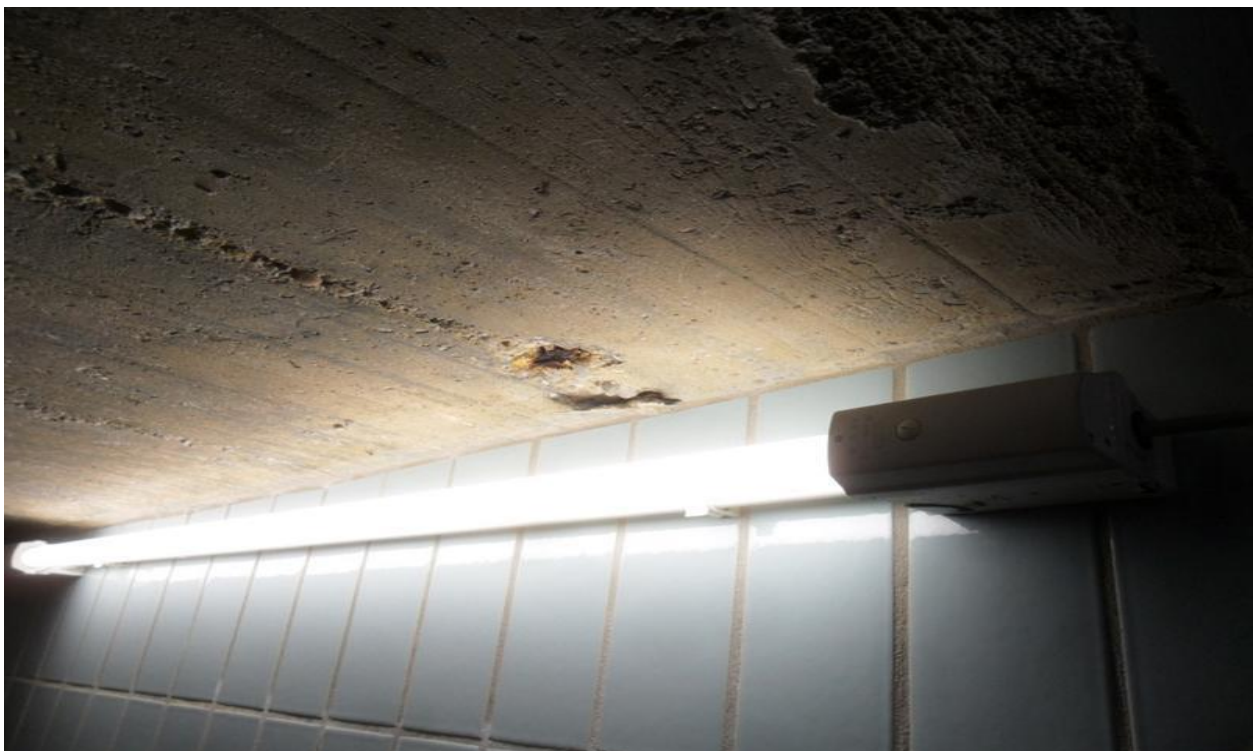
Abbildung 16: Betonschäden Hochbehälter Viehweg
